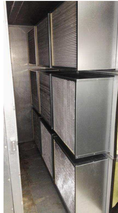
zamontowane nowe filtry dokładne E10 z separatorami alu
