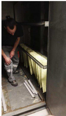
montaż nowych filtrów wstępnych GLASS
