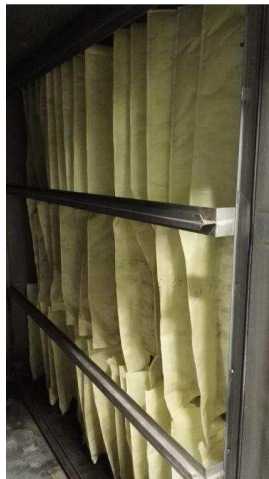
montaż nowych filtrów wstępnych GLASS
