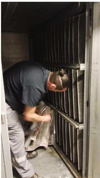
demontaż dotychczasowych filtrów wstępnych G4 i dokładnych F7
