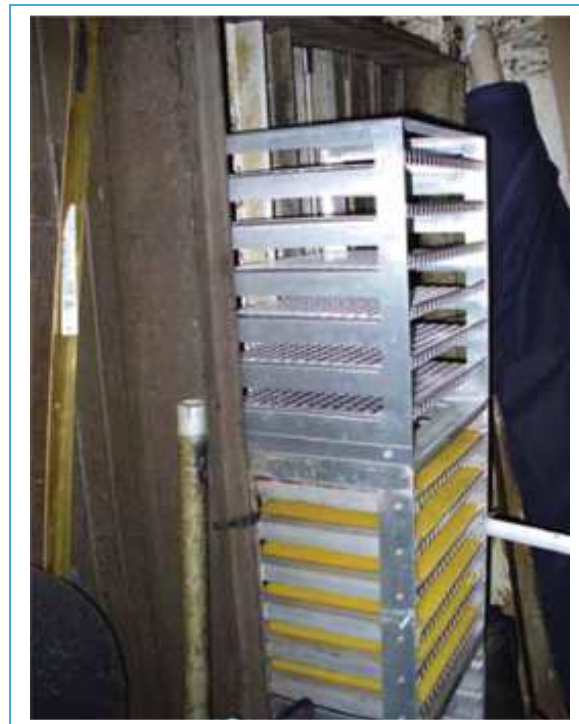
sekcja z panelami w centrali wentylacji
